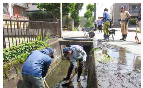
■1支店1協同活動「浚渫作業」
