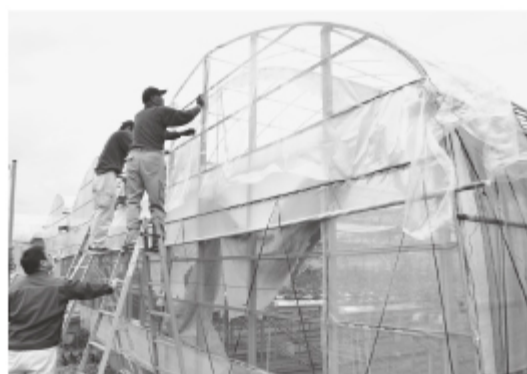
■援農隊によるハウスの補修
