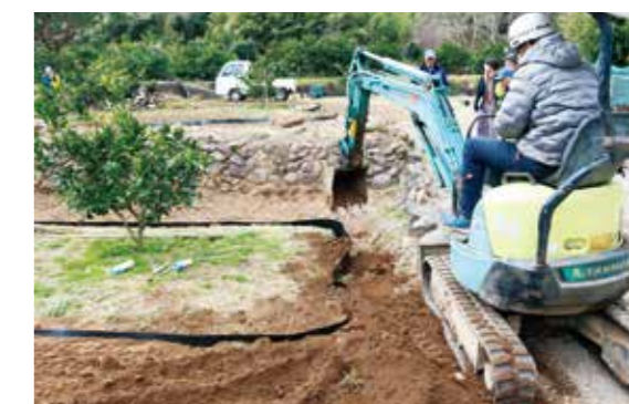
専用シートの埋設作業
